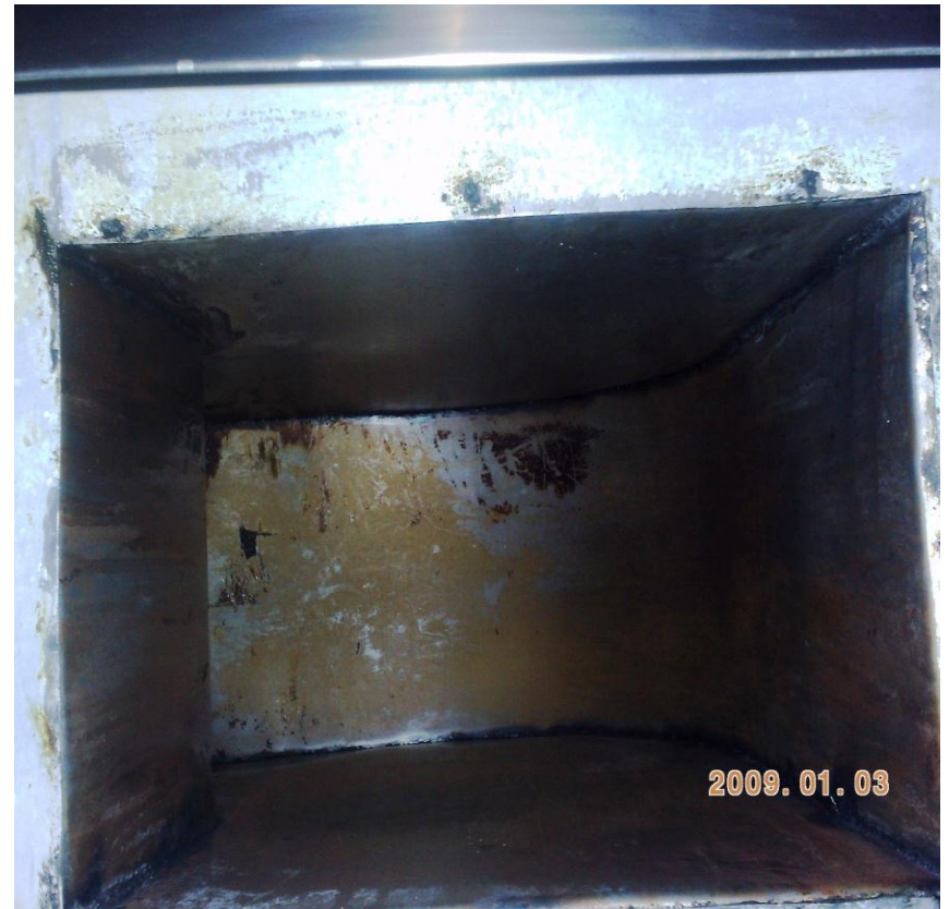
Mismo ducto ya lavado.
