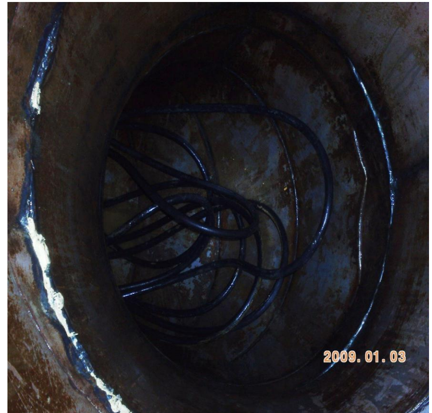
Mismo ducto ya lavado y sellado
